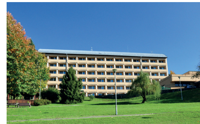
DS Burešov s novou stříbrošedou barvou střechy (2023)
