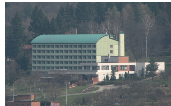
Celkový pohled na DS Burešov po rekonstrukci střechy (1994)
