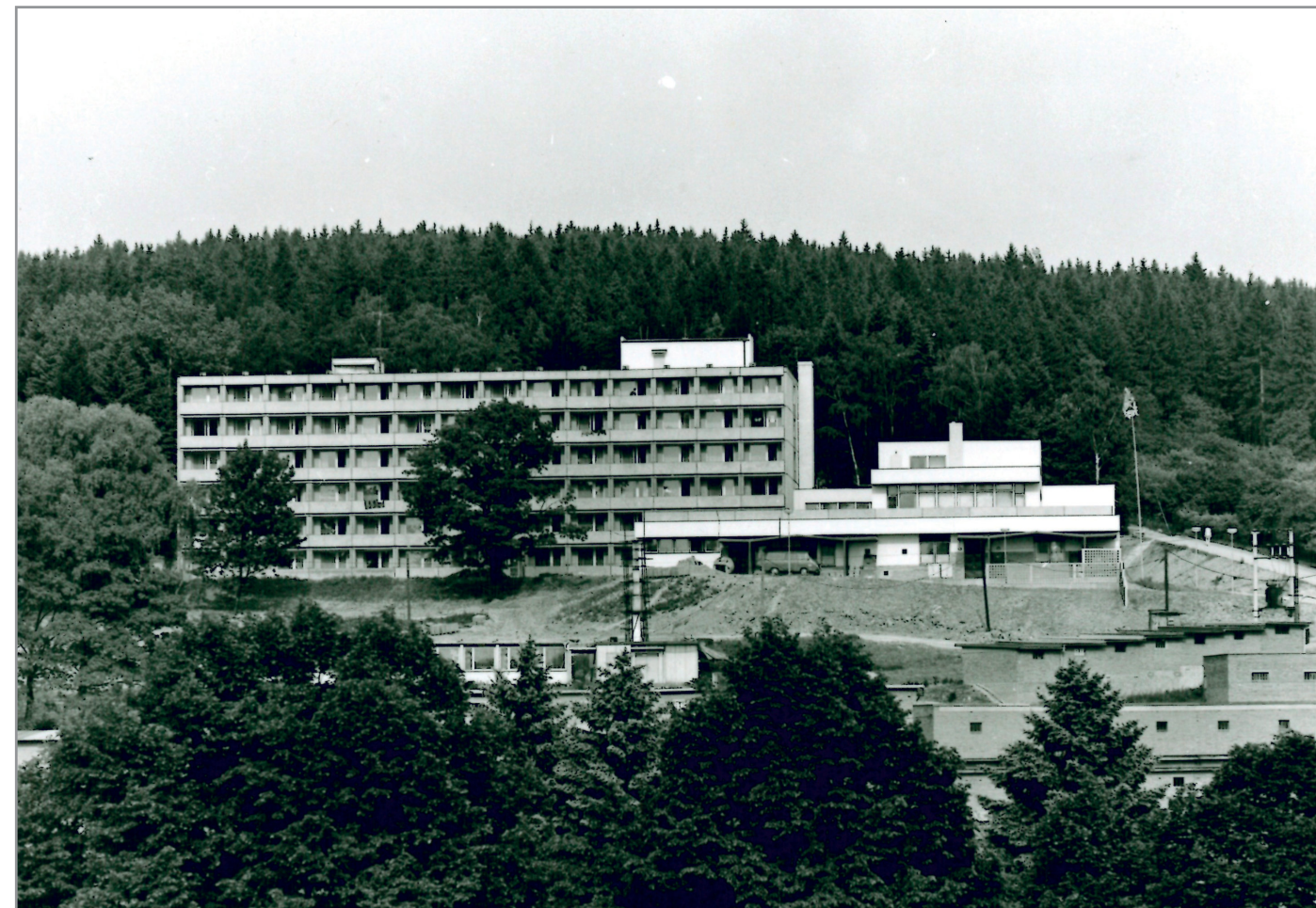
Celkový pohled na čerstvě dokončenou stavbu Domova
